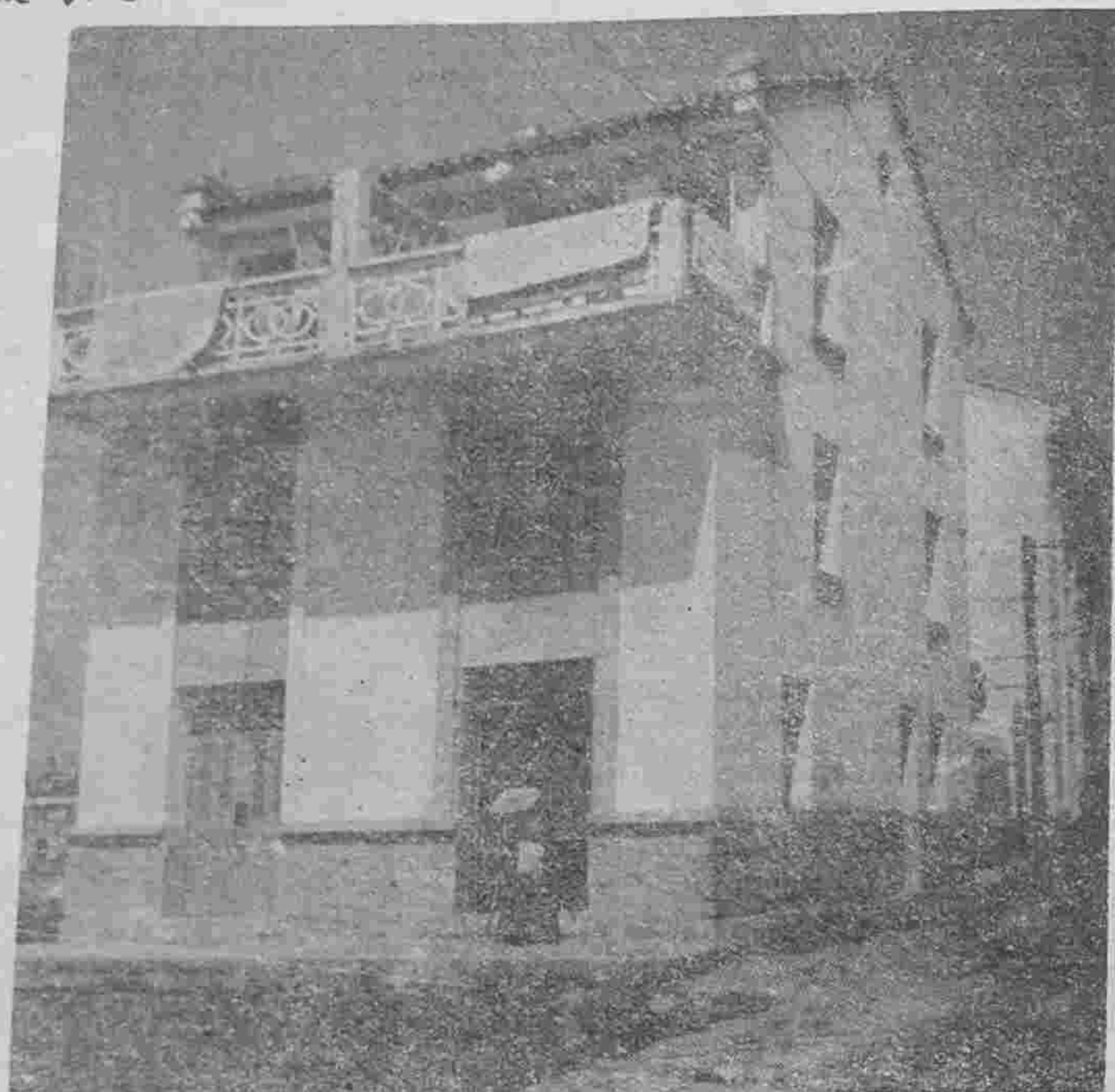
这是平阳县一个贪污盗窃分子新建的高楼，站在门前的是一个外流讨饭的人
